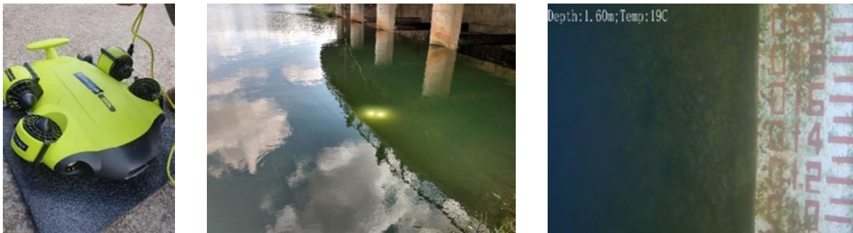
Figura 8: Inspeção de infraestrutura utilizando ROV (Neto et al., 2025)
